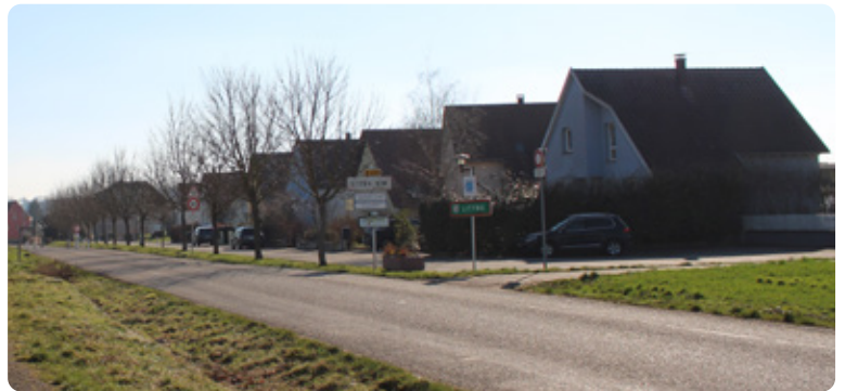
Dans ce village, la voie carrossable est arrêtée par des noues enherbées gérant directement les eaux pluviales par infiltration © Territoires & Paysages
