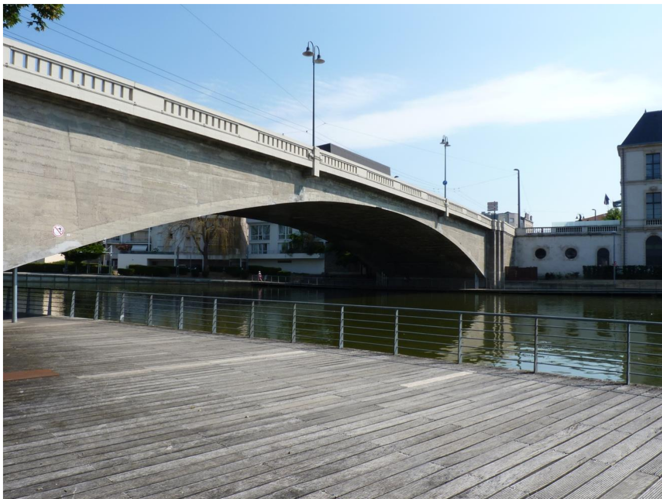
L'entretien des ponts et de leurs abords contribuent également à la qualité de vie de l'espace public
