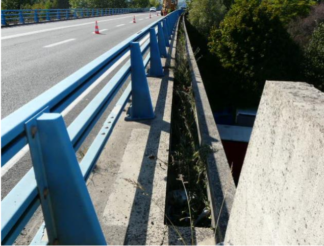
Défauts d'entretien courant qui compromettent le fonctionnement de l'assainissement, du drainage ou la stabilité des ouvrages
