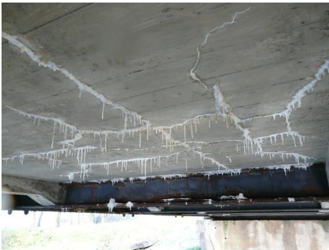
Défauts d'étanchéité, carbonatation du béton armé puis corrosion des aciers, un processus éprouvé !
