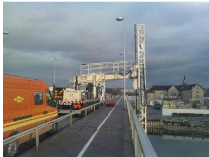
Inspection détaillée avec passerelle négative
