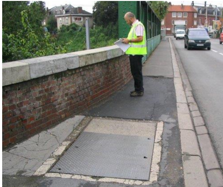
Surveillance périodique sans moyens d'accès particuliers
