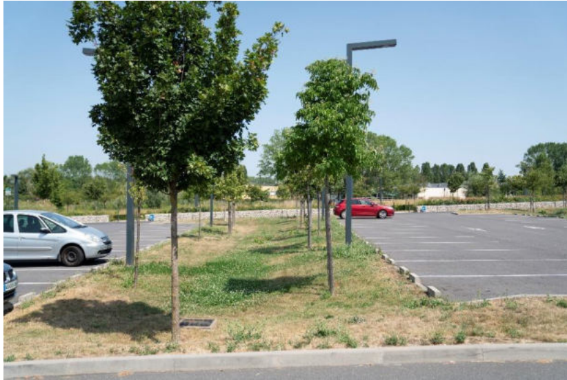
Figure 8 : Noue connectée par surverse à la structure réservoir de la voirie - AERM
