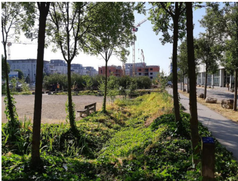
Figure 6 : Noue d'infiltration, Nancy (54) - AERM
