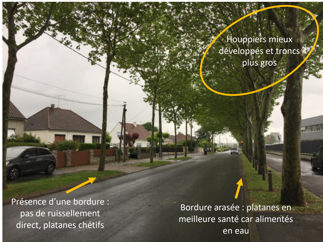
Figure 12 : Exemple d'une rangée de platanes avec bordures hautes et d'une rangée de platanes avec bordures arasées à Crépy-en-Valois (60). Les arbres ont été plantés en même temps - ADOPTA
