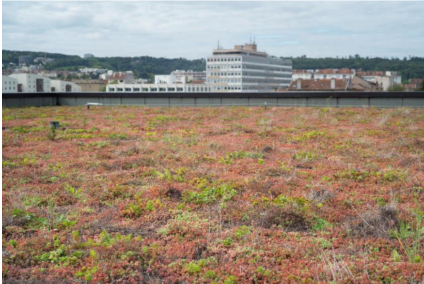
Figure 10 : Toiture végétalisée sur le campus ARTEM à Nancy (54) - AERM
