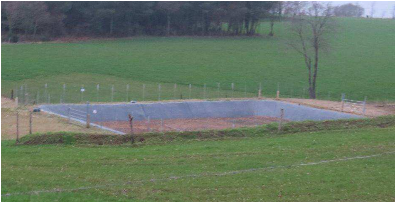
Exemple de fosse pour stockage d'effluents d'élevage (fosse à géomembrane)
