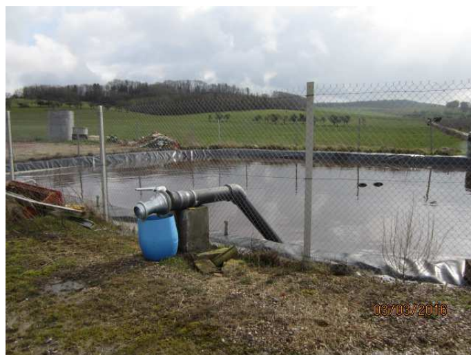
Exemple de fosse collectant les effluents d'élevage (fosse à géomembrane)
