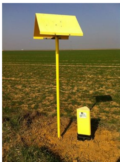
Exemple de balisage d'une canalisation souterraine de gaz
