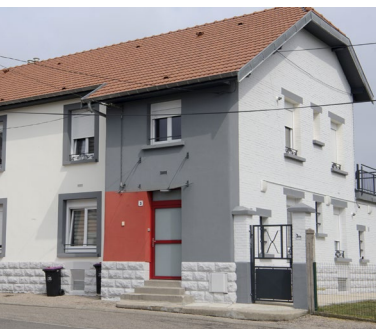
Rénovation de 10 logements communaux portée par la Codecom de Commercy.
