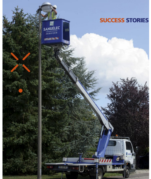
Intervention pour la rénovation de l'éclairage public.
